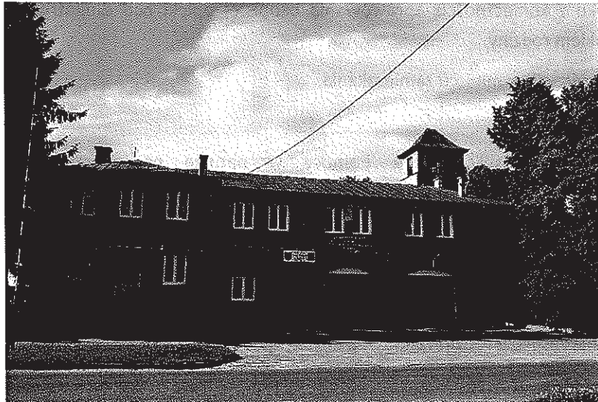
Rysunek 26. Budynek Ochotniczej Straży Pożarnej w Jadowie
